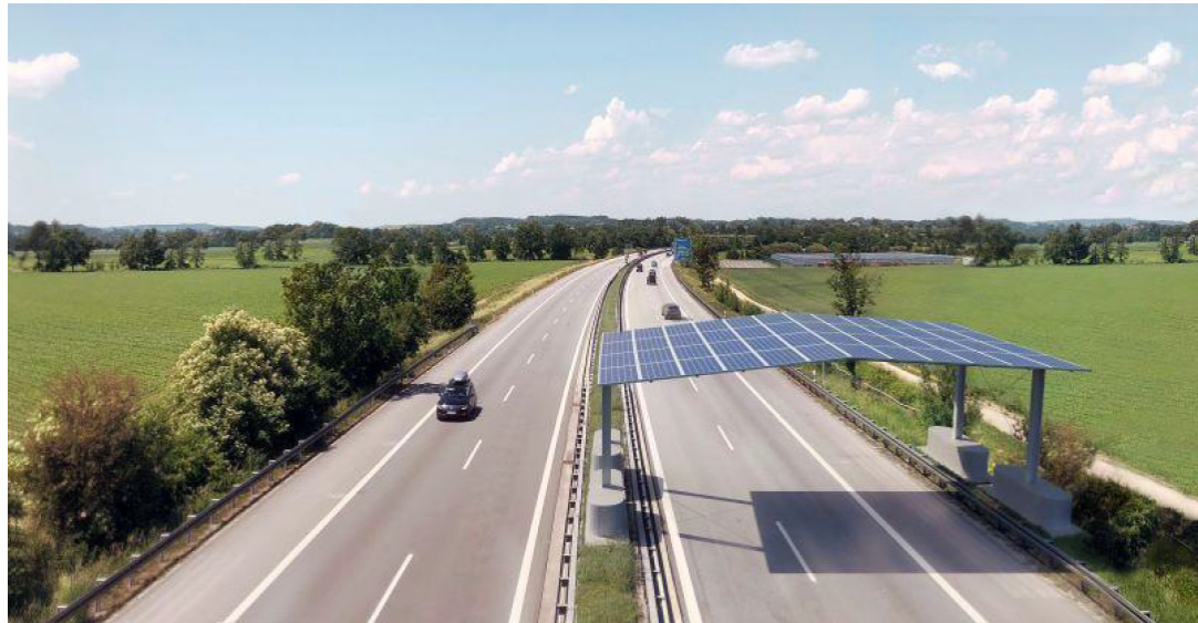
Abbildung 5: Solar Highway Forschungsprojekt des österreichischen Instituts AIT Austrian Institute of Technology (Bild: © AIT Austrian Institute of Technology GmbH)
