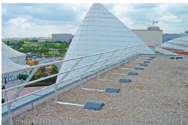
Bild 6 Seitenschutz ohne Dachhautdurchdringung – temporär und permanent einsetzbar
