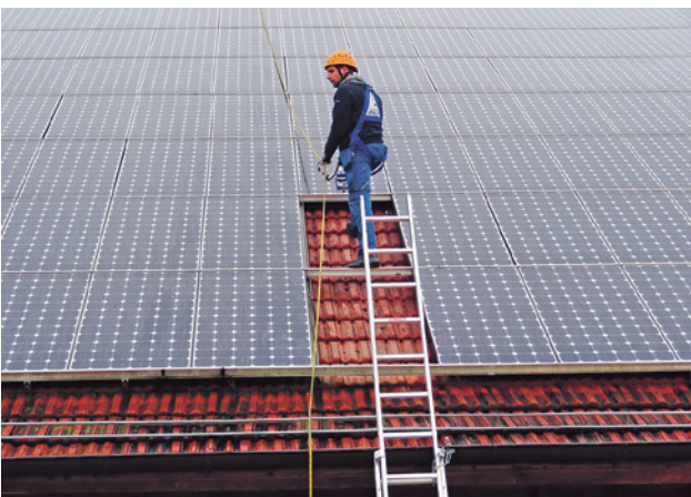
Bild 18 Überwurfseil, mit einem Mitläufer gesichert
