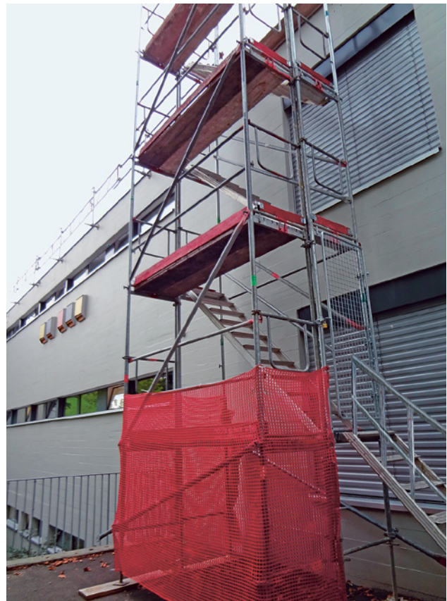
Bild 3 Sicherer Zugang über einen Treppenturm
